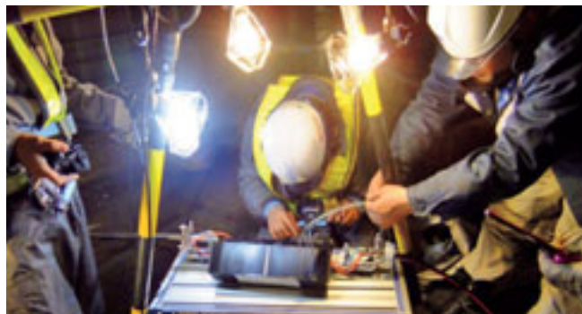
基幹ルートの通信ケーブル復旧作業
