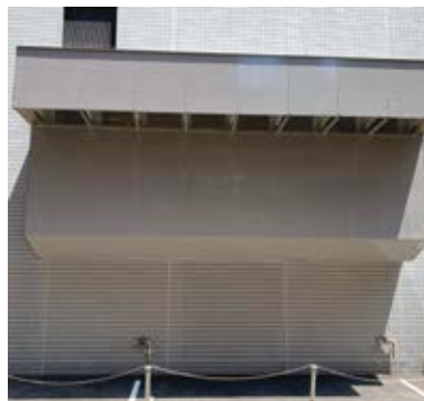
発電機用給排気口ダクト嵩上げ
