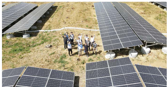
埼玉県熊谷市 発電所外観
