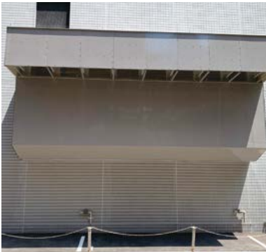
発電機用給排気口ダクト嵩上げ
