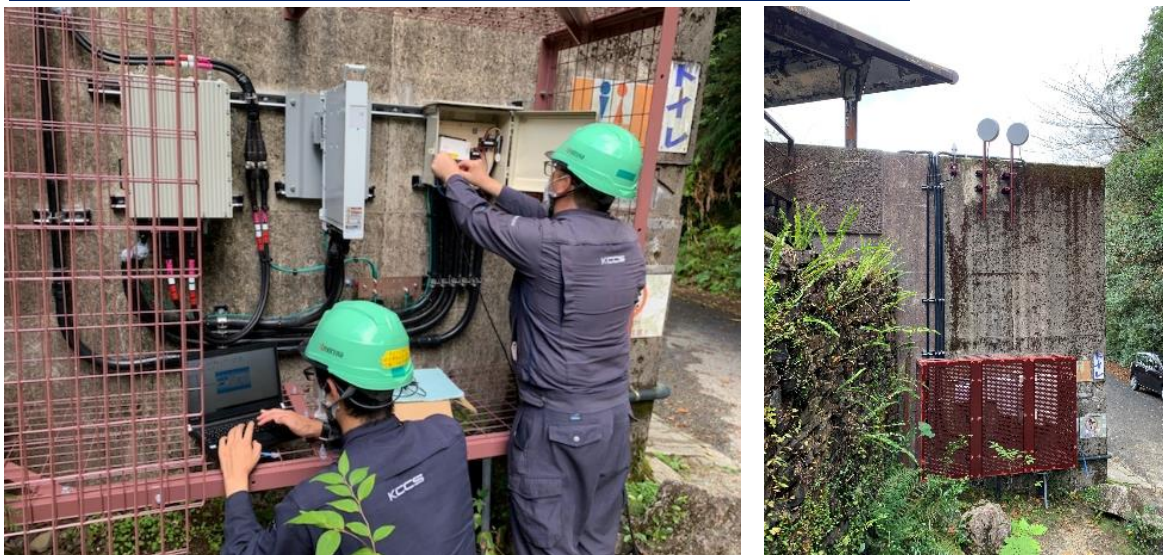
図 12 通信エリア対策工事の様子（左）基地局と小型の丸型アンテナ（右）
