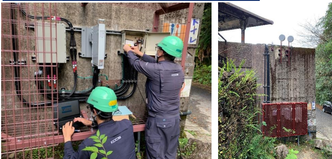
図 13 通信エリア対策工事の様子 (左) 基地局と小型の丸型アンテナ (右)
